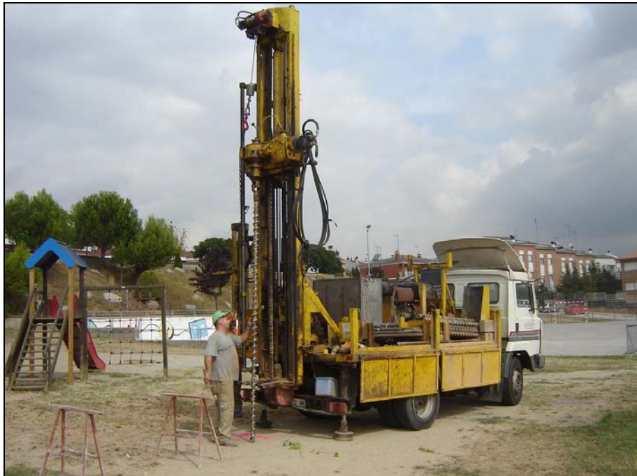
Foto 4: Màquina realitzant el sondeig S-1.
