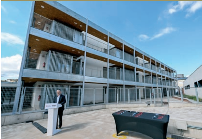
El bloc construït per l'Incasol, al carrer Poeta Joan Maragall, amb Jordi Terrades, dilluns en el lliurament de claus
