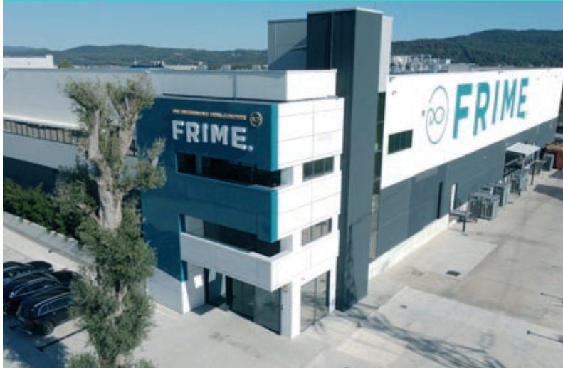
Frime va estrenar el 2021 les instal·lacions principals en una nova planta a la Roca
