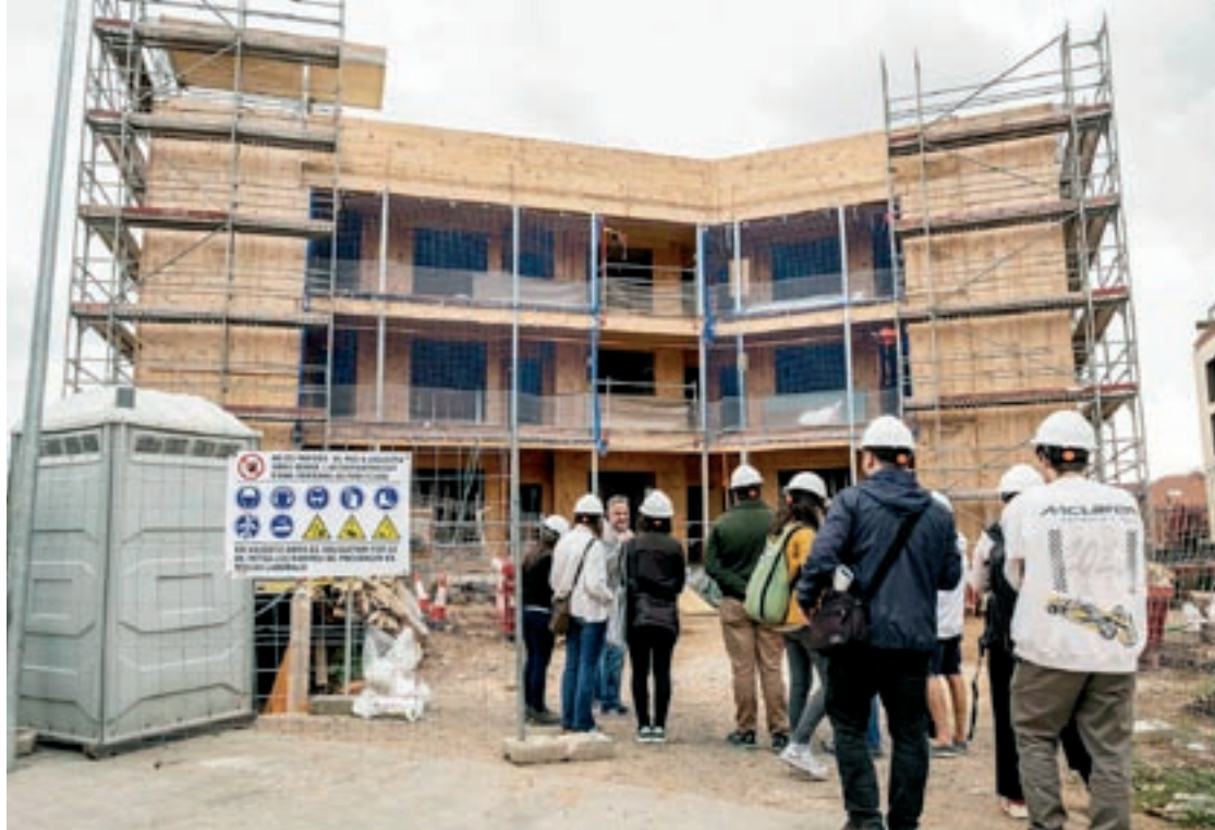
Aquest dilluns membres de l'Ajuntament van fer una visita a les obres dels pisos de la plaça de la Pau de la Garriga
