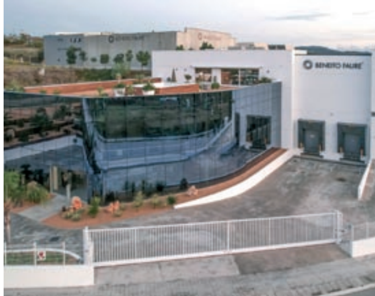
Aspecte de les instal·lacions de Beneito Faure que ha construït Nadico
