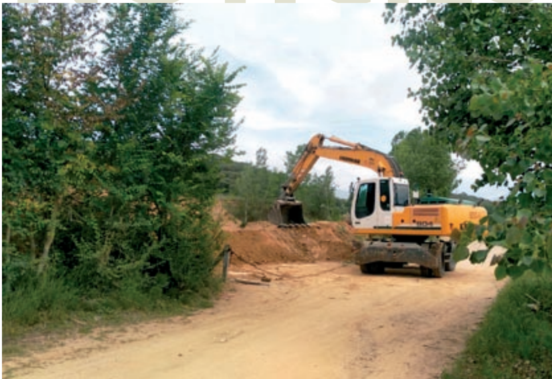
L'excavadora fa els treballs per construir el talús que impedeix l'accés a la zona de la bassa de Llinars
