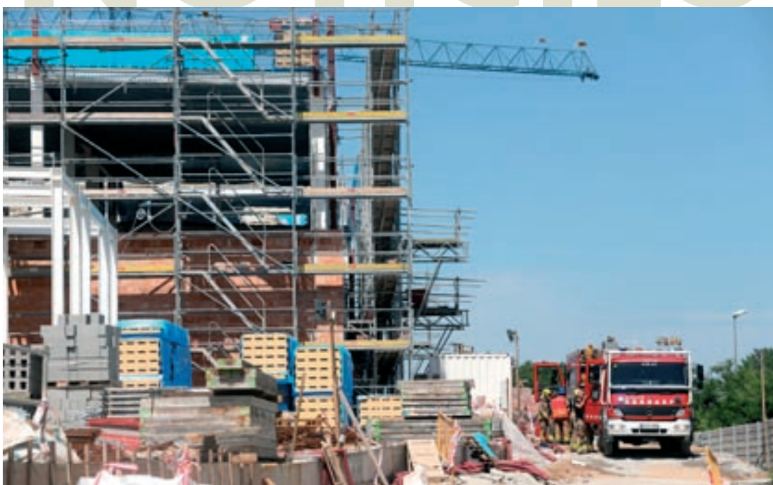
Els bombers van revisar les instal·lacions per assegurar-se que estava totalment apagat
