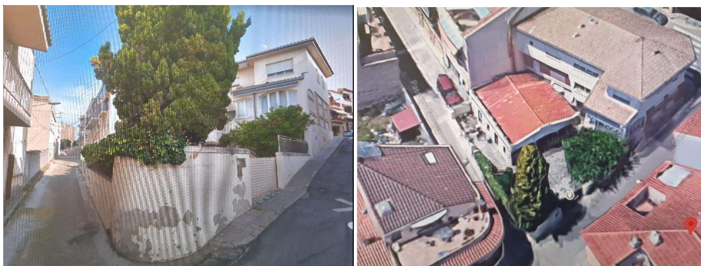
Figura 1. Detall de l'exemplar vist des de l'exterior de l'immoble del Passatge Espanya nº 9-11.
