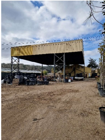
Estat actual del edifici Texaco (nº8)
