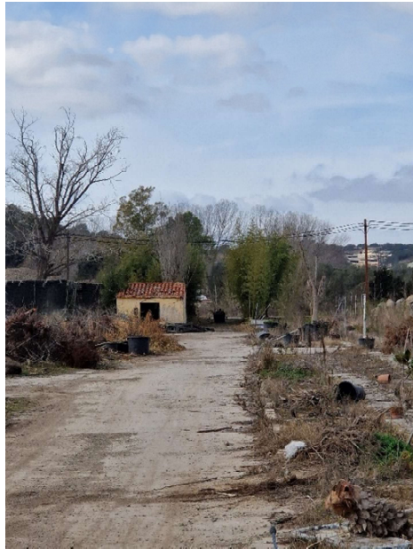
Estat actual de la caseta del pou
