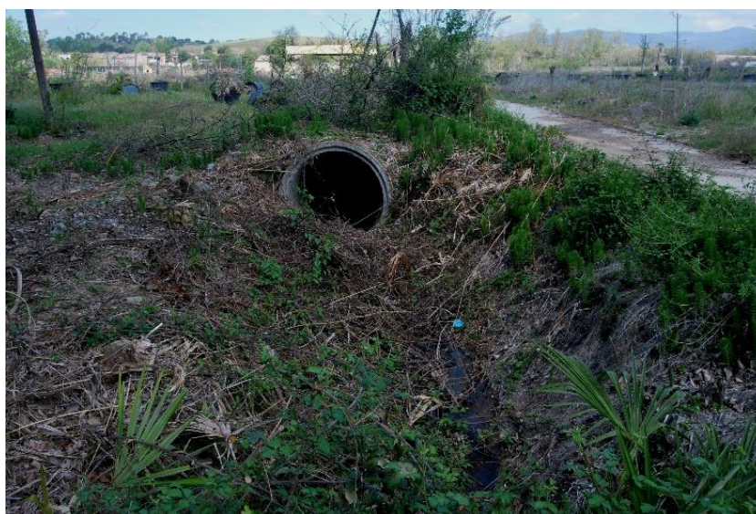
Figura 4.7 Torrenteres. Potencial restauració com a corredor ecològic. Font: Minuartia.
